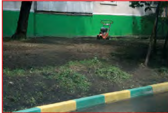
09.07.2013. Вы думаете это замена газона? Нет! Это, оказывается, такой ремонт газона у дома 14 корп.1 по Б. Черкизовской ул.
